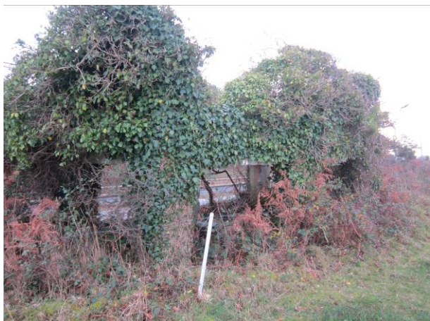
Bâtiment n° 10 – Poste d’observation Sans intérêt.
